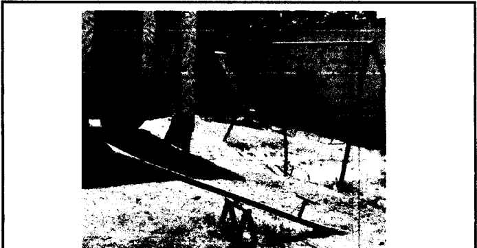
Foto 2: Mejoramiento de juegos metálicos en mal estado.
