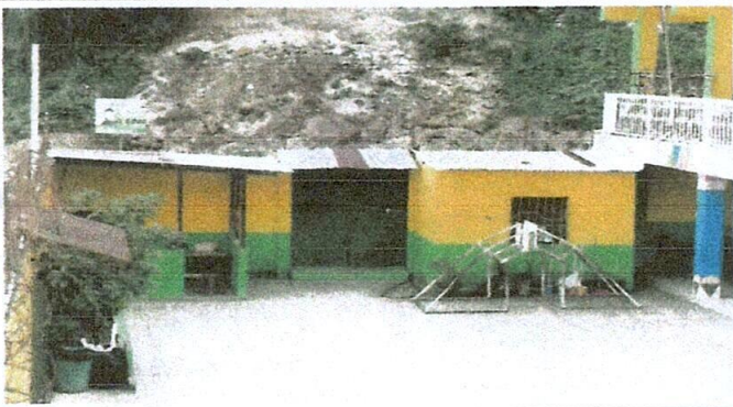
Foto: 3 AMPLIACION DE COCINA
