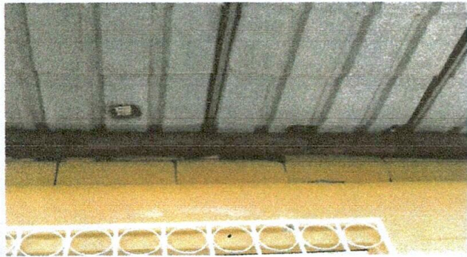
Foto: CAMBIO DE TECHO DE LAMINA
