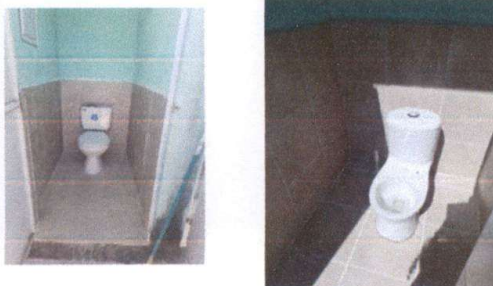
Foto 5: Piso en sanitarios (5)
