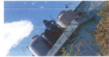
Foto 4: Mariles de instalación de tinaco para agua potable.
