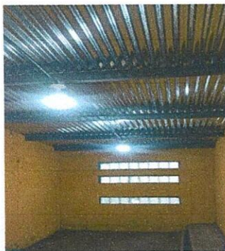
Foto 11: Cambio de Láminas y costaneras en Bodega.
