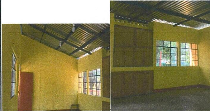
Foto 7: Pintura en paredes de dos aulas, resanado de paredes, pintura de dos manos.
