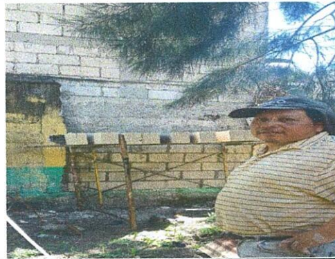
Foto 4: Demolición y reconstrucción de muro perimetral rajado en área de patio trasero.
