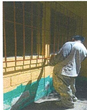
Foto 8: Pintura de balcones de dos aulas
