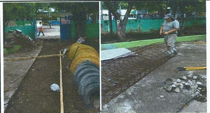
Foto 6: Caminamiento de concreto 20 mts 2
