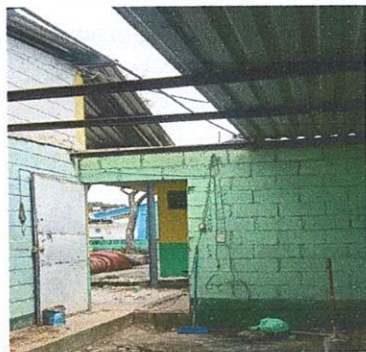
Foto 11: Cambio de Láminas y costaneras.
