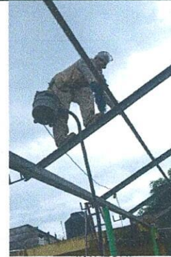
Foto 2: Mantenimiento de estructura de soporte de metal (lijado, aplicación de 2 manos de pintura anticorrosiva) Suministro e instalación de canal calibre 26. Suministro e instalación de cambio de costanera de 4 x 2 pulg.
