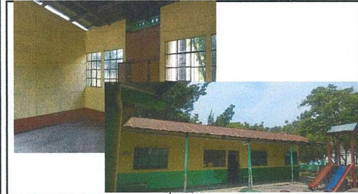
Foto 7: Pintura en paredes de dos aulas, resanado de paredes, pintura de dos manos.
