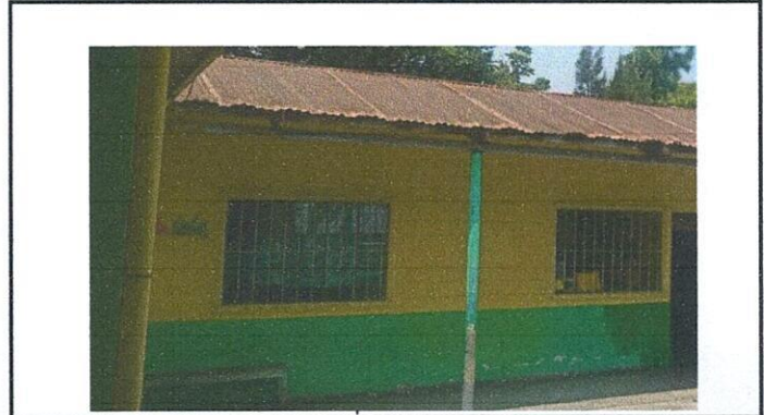
Foto 8: Pintura de balcones de dos aulas
