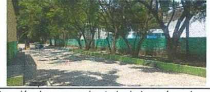
Foto 4: Demolición y reconstrucción de muro perimetral rajado en área de patio trasero. Muro perimetral cepillado, resanado y pintado
