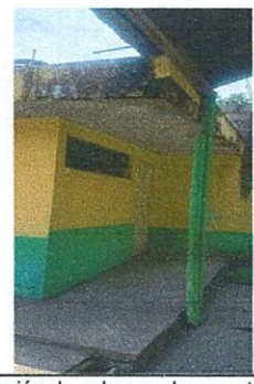
Foto 3: Suministro e instalación de columna de soporte en área de bodega de párvulos, tubo redondo de 6.5 pulgadas de diámetro de metal con concreto interno de 2.48 mts.
