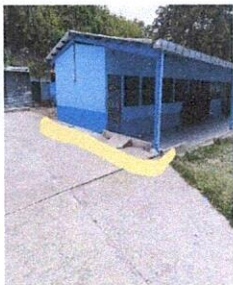
Foto: 5 Aplicación de pintura
