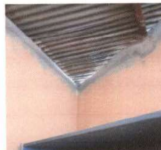
Foto 6: Levantado de techo en cocina/bodega
