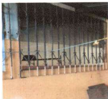
Foto 3: instalacion de ventana en cocina
