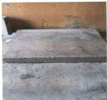
Foto 1: Limpieza y mejoramiento de fosa septica
