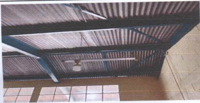
Foto 1: Pintura en estructura y cambio de láminas
