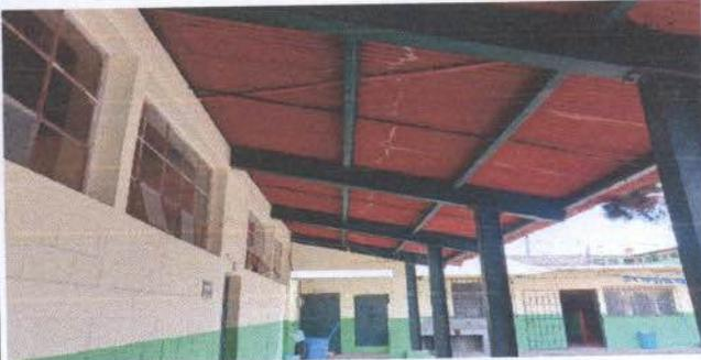
Foto 3: Sustitución de láminas galvanizadas por troqueladas
