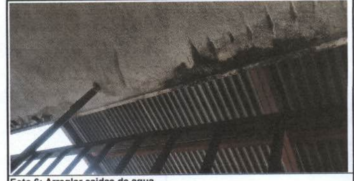
Foto 6: Arreglar caídas de agua.
