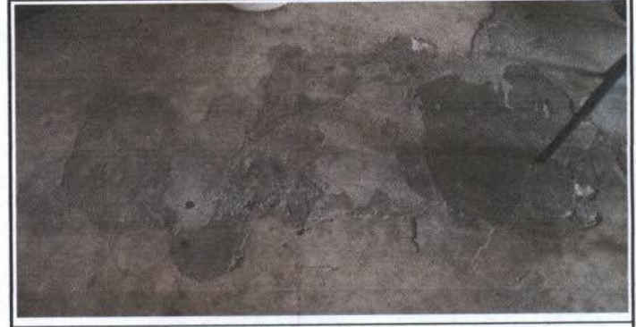
Foto 4: Cambio de piso en los salones de clases. (4)
