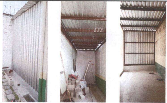
Foto: 4 Techo de bodega finalizado
