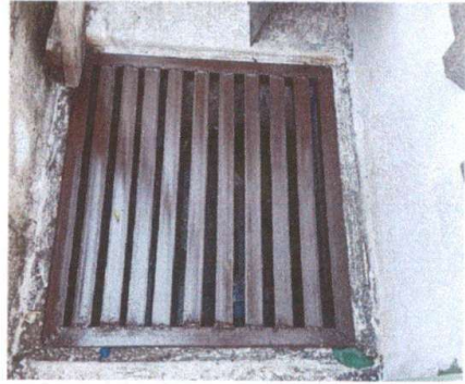
Foto: 2 Cuneta finalizada, con cubierta
