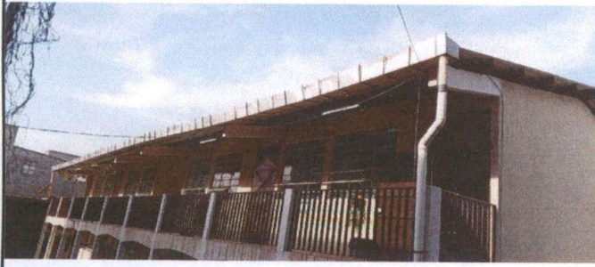
Foto: Canal reparado
