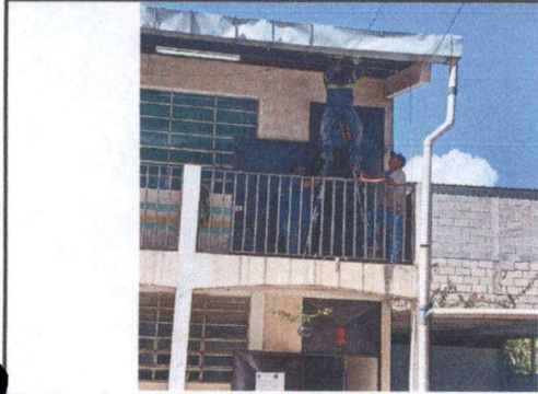
Foto: Canal en reparación
