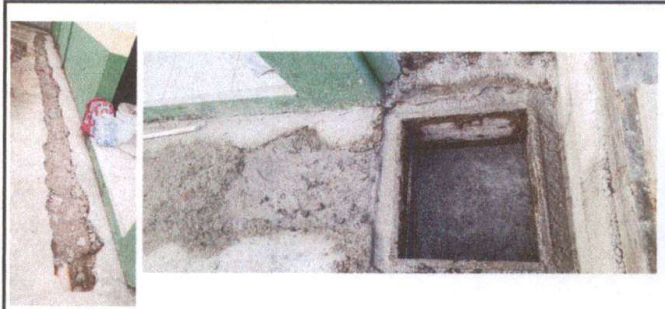
Foto: 2 Cuneta en proceso
