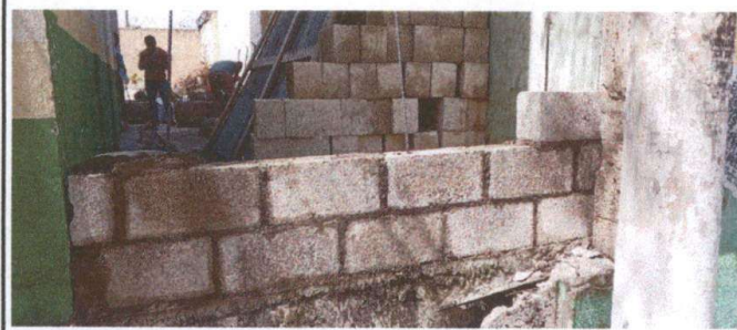
Foto: 3 Completación de muro perimetral
