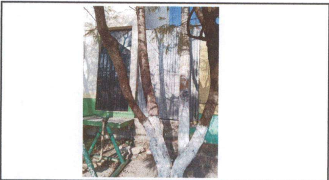
Foto: 3 Muro perimetral a completar
