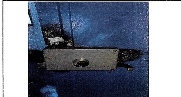
Foto 2: SUSTITUCION DE CHAPAS EN MAL ESTADO
