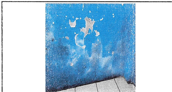
Foto 5: REPARACION DE REPELLO EN PARED + IMPERMEABILIZACION
