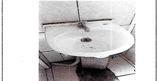
Foto 2: SUSTITUCION DE LAVAMANOS POR LAVAMANOS FUNDIDOS
