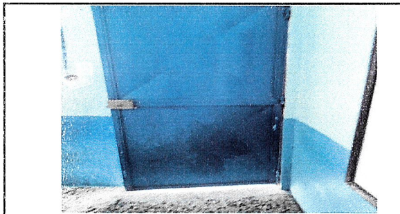
Foto 3: MANTENIMIENTO DE PUERTAS, LIJADO Y PINTADO.
