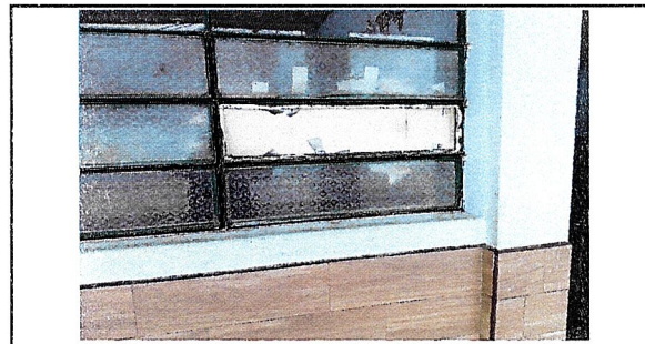
Foto 4: SUSTITUCION DE VIDRIOS EN MAL ESTADO, E INSTALACION DE BALCON METALICO.
