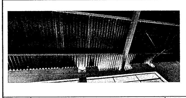
Foto 6: MÓDULO NO. 3 AULAS QUE NECESITAN LA SUSTITUCIÓN DE LÁMINA DEBIDO A ESTAR DETERIORADAS POR EL TIEMPO DE USO
