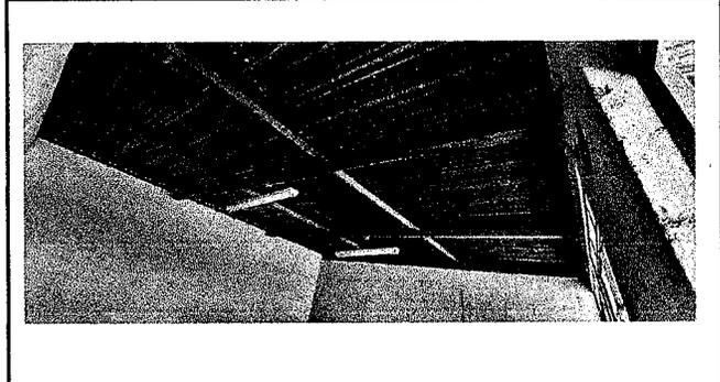
Foto 4: MÓDULO No. 2 AULAS NECESITA LA SUSTITUCIÓN DE LÁMINA DEBIDO A LAS GOTERAS EXISTENTES
