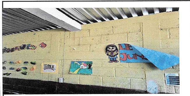
Foto 3: Área del salón 2 de clases en donde se hará trabajo de repello y pintura en los salones de clases.
