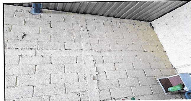
Foto 4: Salón de clases que se arreglará sistema eléctrico.
