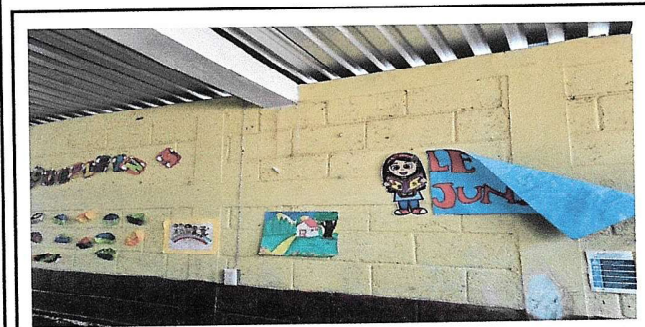
Foto 5: Continuación con el área en donde se arreglará la electricidad.
