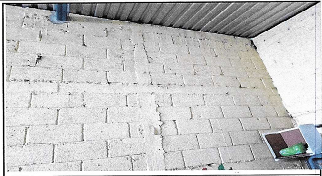
Foto 2: Área de salón de clases 1 en donde se hará el trabajo de repello y pintura en los salones de clases.
