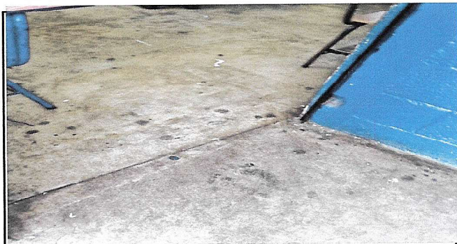
Foto 3: Área del salón 3 de clases a trabajar en instalación de piso.
