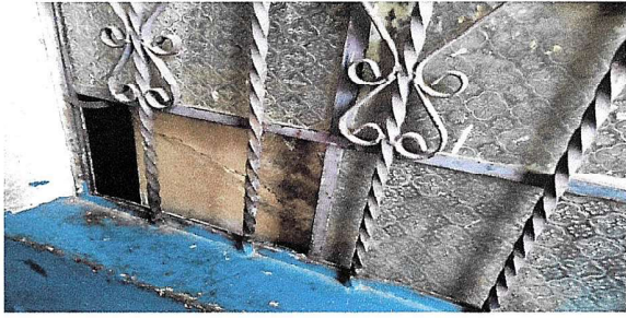
Foto1: Reemplazo de vidrios de ventanas.
