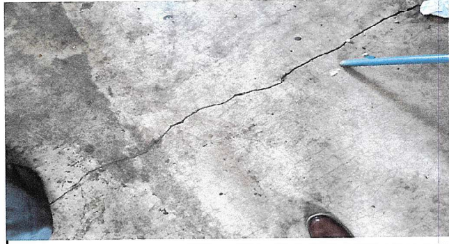
Foto 4: Salón 4 de clases se trabajará instalación de piso.
