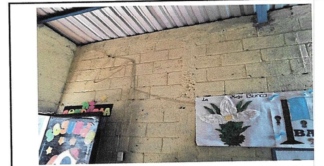
Foto 6: Corrección de área dañada con la electricidad.
