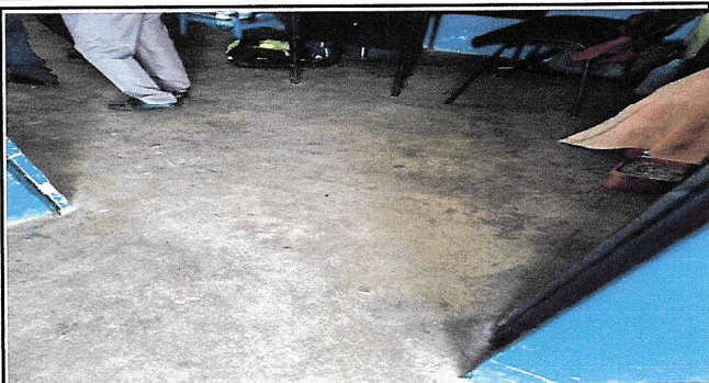
Foto 1: Área de salón 1 de clases, para poder instalar piso.
