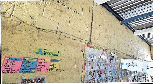
Foto 1: Área de salón de clases, para poder trabajar reparar sistema eléctrico
