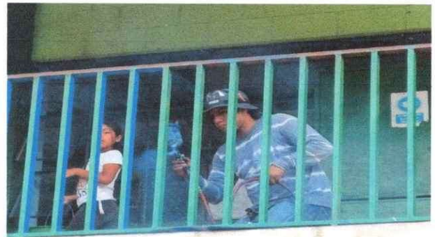
Foto 4: lijado y pintado de barandas
