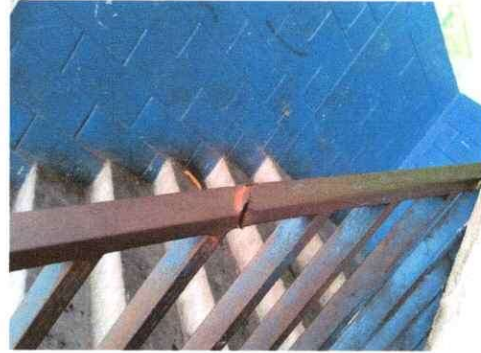
Foto 2: sustitucion de baranda de gradas
