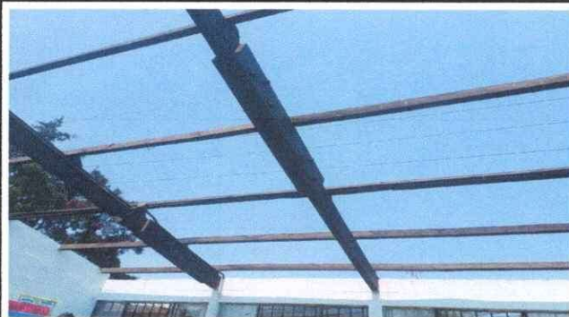
Foto 5: desmontando la vigas de madera
