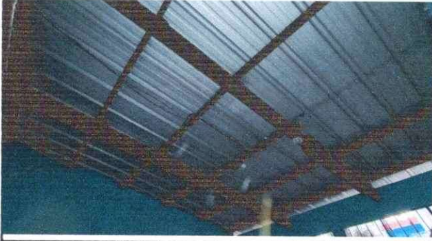
Foto1: sustitucion de vigas y laminas
