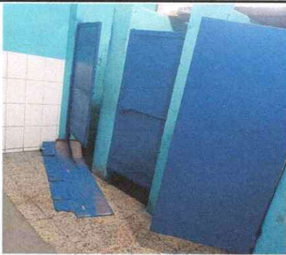
Foto 3: lijado y pintado de puertas de sanitarios
