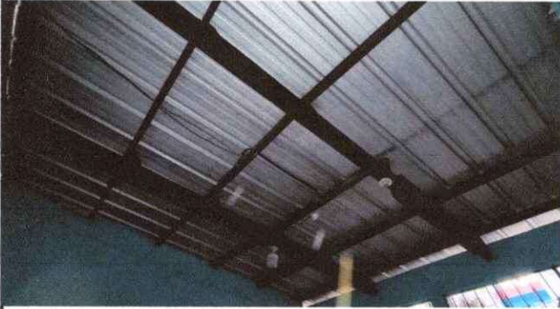
Foto1: sustitucion de vigas y laminas
