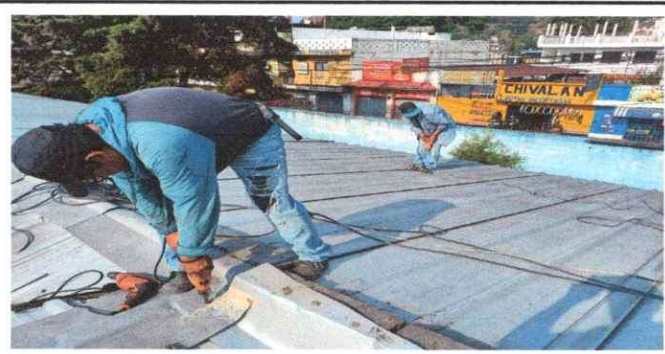
Foto 6: Desmintando el techo
