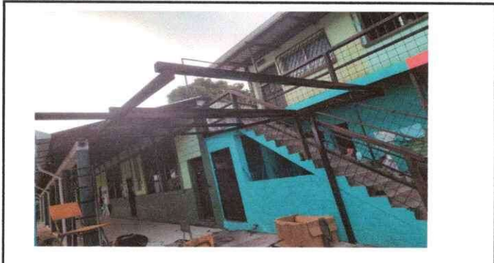
Foto 2: techo para las pilas
