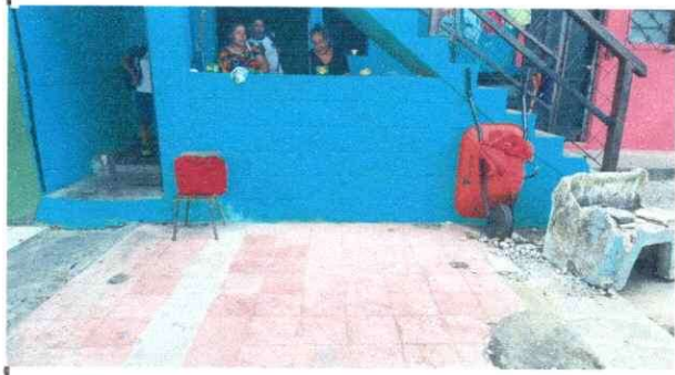
Foto 4: Colocacion de 2 pilas
