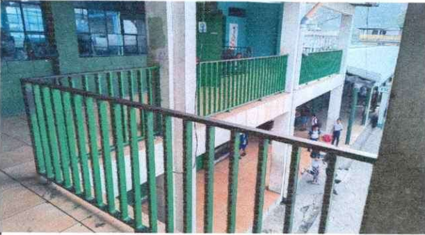
Foto 3: pintar y ajustar barantas de segundo nivel
