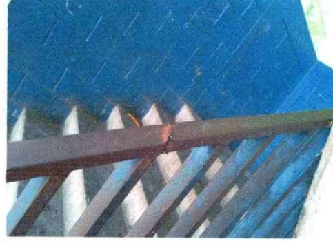
Foto 2: sustitucion de baranda de gradas
