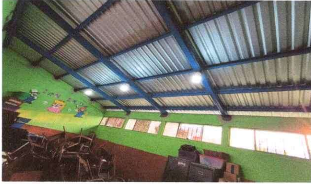
Foto1: sustitucion de vigas y laminas
