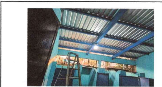
Foto 3: techo de los sanitarios
