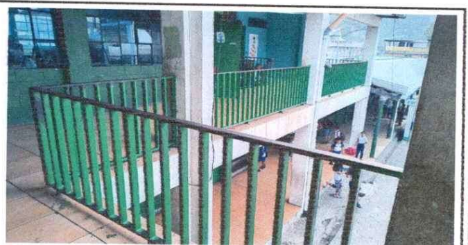
Mantenimieto de barandas de metal
