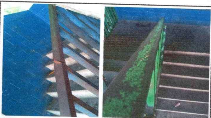
Sustitucion de barandas de metal
