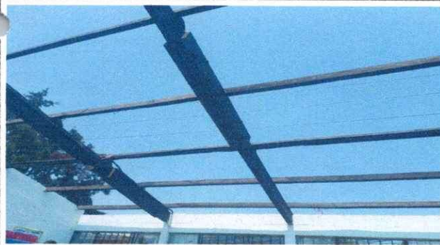
Foto 5: desmontando la vigas de madera
