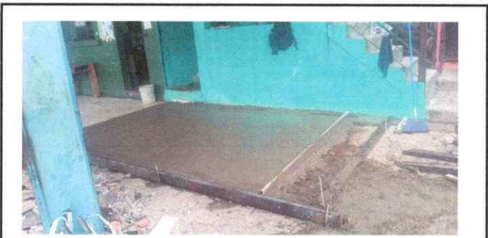
Foto 6: fundicion de tota para colocar las pilas
