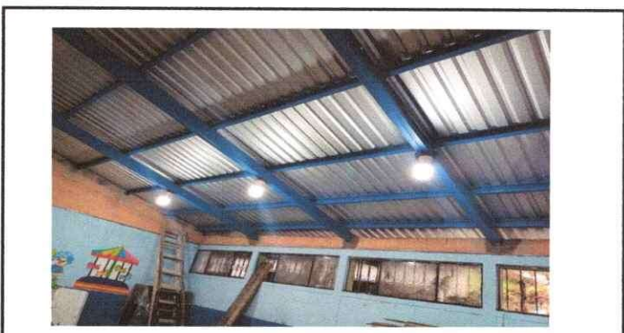
Foto 4: instalacion de laminas y estructura metalica e intalacion electrica
