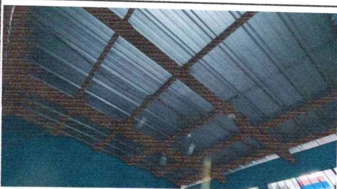
Sutitucion de estructura de soporte de madera, por metal.
