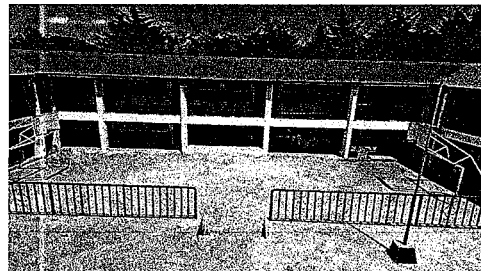
Foto 16: Refuerzo de banrandal perimetral del segundo nivel, agregando 330 barrotos de metal.
