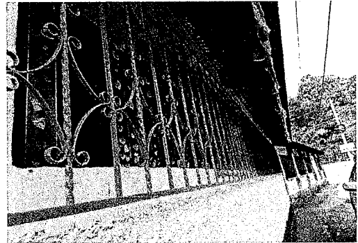
Foto 4: MANTENIMIENTO A BALCONES Y VENTANAS
