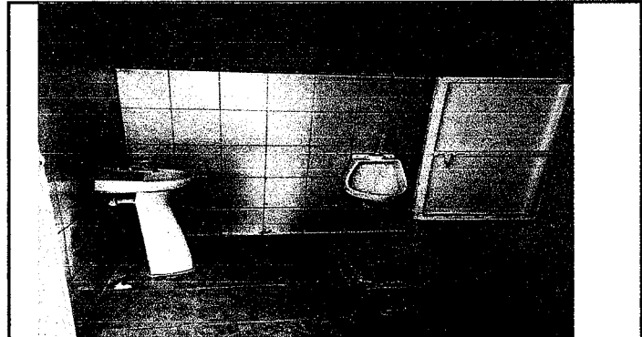
Foto 2: Sanitarios de niños, demolición de pared y ampliación con 2 sanitarios.
