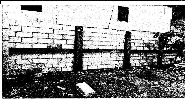
Foto 1: Reparación de muro perimetral de bloques con medida 8.70 largo por 2.60 de altura con cemento corrido de 0.40x0.20 y 3 columnas resaltadas 0.20x0.25 materiales y mano de obra
