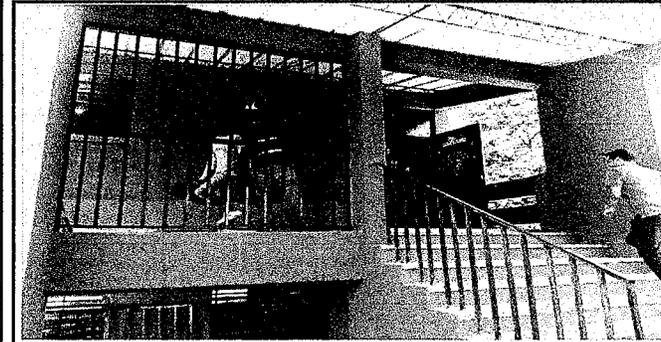
Foto 1: Fabricación e instalación de puerta de rejas de metal 2.35x 2.30
