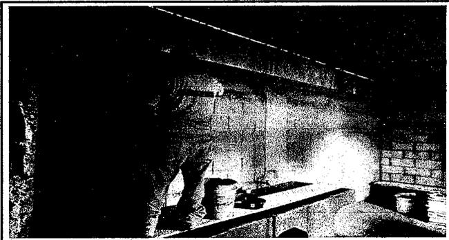
Foto 3: Repello de muro de la cocina
