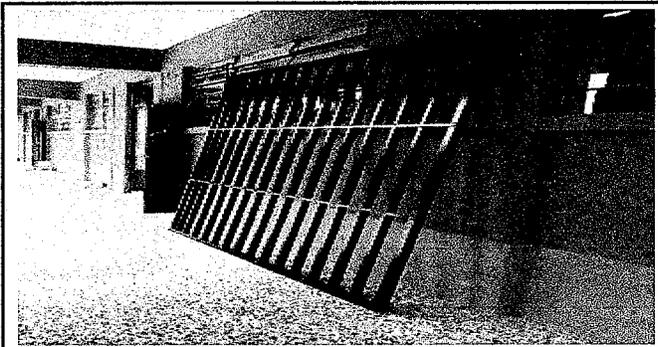
Foto 3: Fabricacion e instalacion de puerta de reja de metal de 2.35 x 2.30 con tubo 1 1/2" x 1 1/2"x1 chapa riel stanley rodos staley
