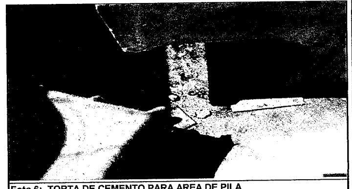
Foto 6: TORTA DE CEMENTO PARA AREA DE PILA
