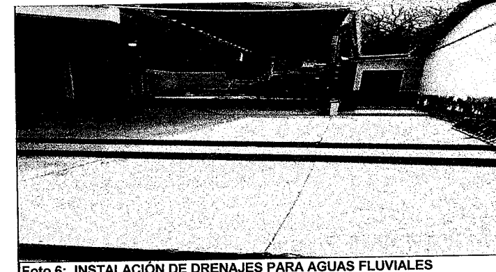
Foto 6: INSTALACIÓN DE DRENAJES PARA AGUAS FLUVIALES
