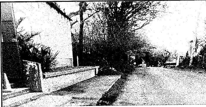
Foto 1: INTRODUCCIÓN DE DRENAJE PARA AGUAS FLUVIALES Y RESIDUALES
