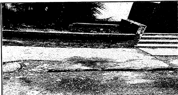
Foto 3: LA SALIDA DEL AGUA HACIA CALLE QUEDO COLAPSADA POR TRABAJOS DE RECAPEO EN LA CARRETERA PRINCIPAL Y EL AGUA AFECTABA A TERCERAS PERSONAS
