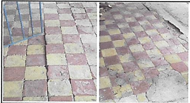
Foto 3: Sustitución de Piso de granito por azulejo
