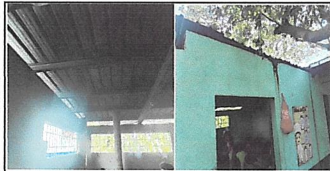
Foto 5: Reparación y sustitución de área de cocina
