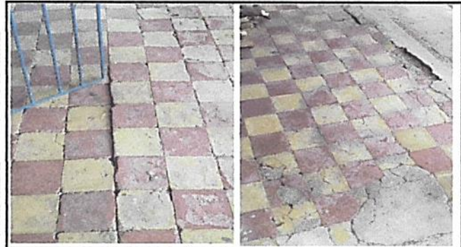
Foto 3: Sustitución de Piso de granito por azulejo
