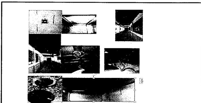
FOTO 5: Sustitución de flafoneras, focos interior y exterior de aulas, apagadores, iamparas de exterior para patio y rampa de acceso.
