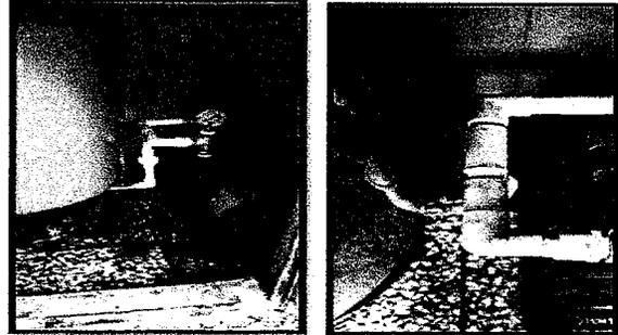
foto 8: sustitución de tubería lineal para bomba de agua, remoción de la que se tiene por fuga y deterioro de los accesorios por sobrecalentamiento
