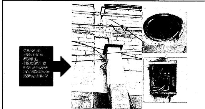
Foto 1: acometida de luz eléctrica, reubicación de caja RH, se realiza la polarización del edificio utilizando 2 varillas de cobre ya que tras inspección se carece de las mismas.
