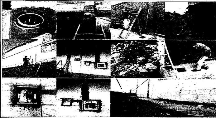
**Foto 1:** se inició con sustitución y detalles del contador, se cambio caja RH al interior del edificio, se polarizo la red eléctrica del edificio y aula de computación colocando 2 varillas de cobre
