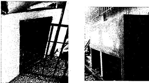
Foto 9: fabricación e instalación de 1 puerta de metal con chapa para el área de bomba de agua, 2 puertas de metal y 2 tapaderas de metal para contenedor de basura
