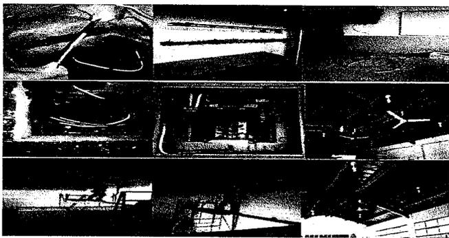
**Foto 3:** trabajo de cableado y ducto para bombillas, apagadores, cables que se encontraban al aire o expuestos
