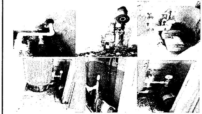
Foto 8: sustitución de tubería lineal para bomba de agua, remoción de la que se tiene por fuga y deterioro de los accesorios por sobrecalentamiento
