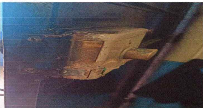
FOTO 3 : CAMBIO DE CHAPA DEL AULA PÁRVULOS 2 SECCIÓN "A"
