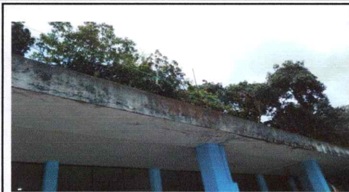
FOTO 1 : APLICACIÓN DE IMPERMEABILIZANTE
