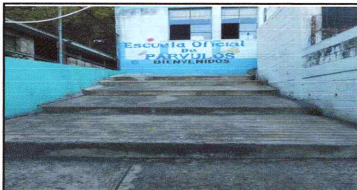
Foto 6: RAMPA DE ACCESO
