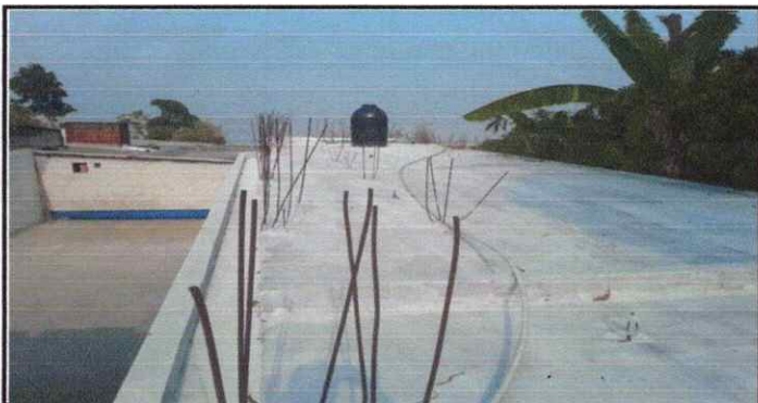
FOTO 5 : COLOCACIÓN DE IMPERMEABILIZANTE
