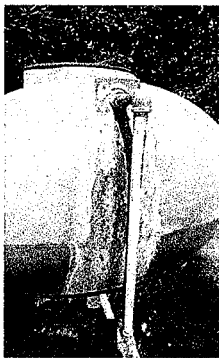
Foto 3: Modulo 18 sustitución de tinacos
