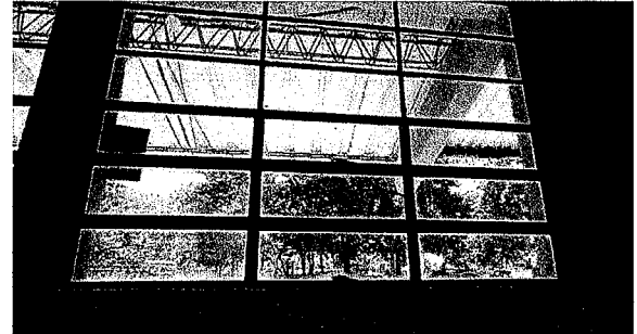
Foto 2: Modulo 5 mantenimiento a estructura de metal de ventana
