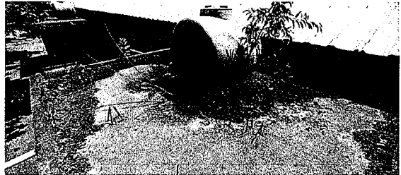
Foto 2: Modulo 18 sustitución de tinacos
