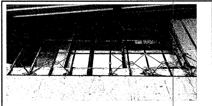
Foto 2: Reparacion y mantenimiento de valcones e instalacion de vidrios del area de salon principal
