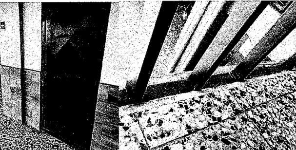
**Foto 6:** Sustitucion de puertas de metal en exteriores y chapa de baños de mujeres y hombres. Colocacion de muro de concreto para subir las barandas debido que se reposa el agua y se oxidaron.
