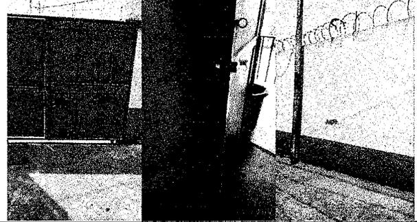
**Foto 2:** Pintura muros interiores, cambio de puertas de metal sanitarios, sustitucion de piso de cemento, sustitucion de lamparas, interruptores, mantenimiento de pintura en estructura del portón.
