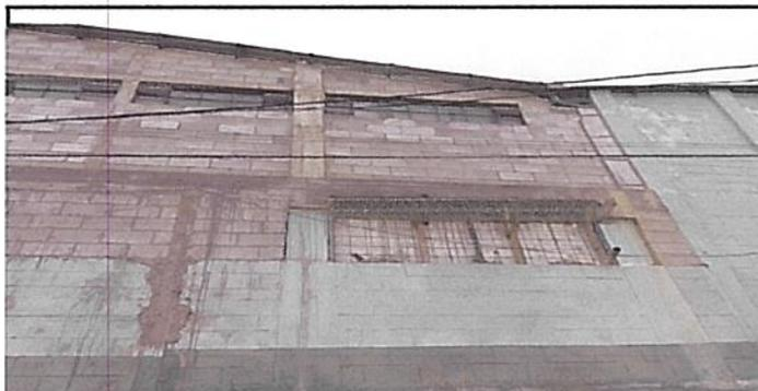
Foto 4: Terminar pegado de block en esta área específicamente
