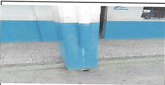
Foto 5: Sustituir tubos de PVC color blanco de caída de agua pluvial
