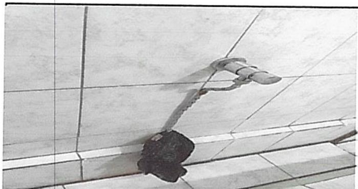
Foto 4: Sustituir sistema de agua y llaves para migitorios
