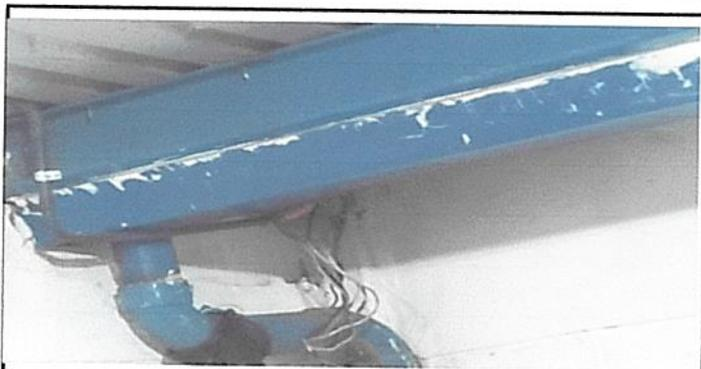
Foto 3: Sustitucion de canal completo en la que se encuentra fuga de agua especificamente cuando llueve
