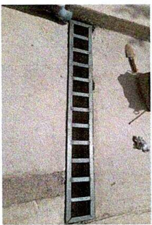
Foto: SE REALIZANDO LA CUNETA PARA DEJAR CAIDA DE AGUA DE SANITARIOS QUE TERMINE EN EL DRENAJE.
