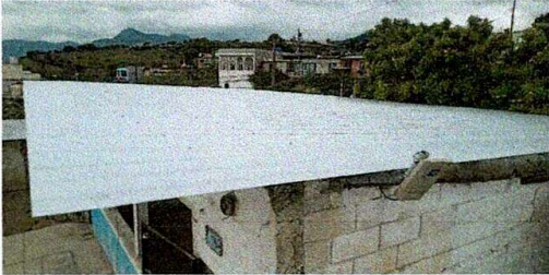
Foto 1: COSTANERA E INSTALACION DE LAMINA TROQUELADA TERMINADA.
