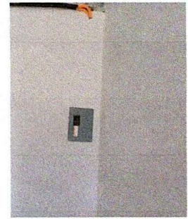
Foto 4: se finalizon la instalaciion de de luz como caja.
