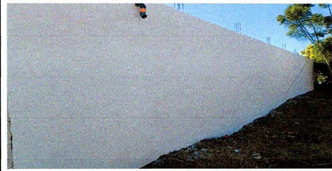
Foto 1: ESTA TERMINANDO EL MURO QUE DA A LA CALLE
