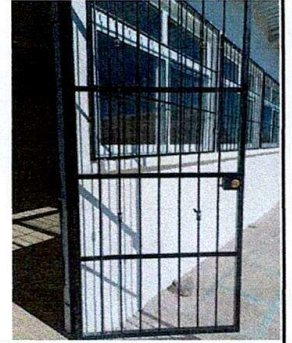
Foto 2: 2 SALÓN 1RO PRIMARIA J.M. INSTALACION DE VENTANAS TERMINADAS, PUERTA Y BARANDAL TERMINADO.
