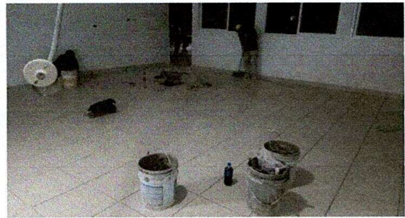
Foto 4: COLOCACIÓN DE PISO TERMINADO.
