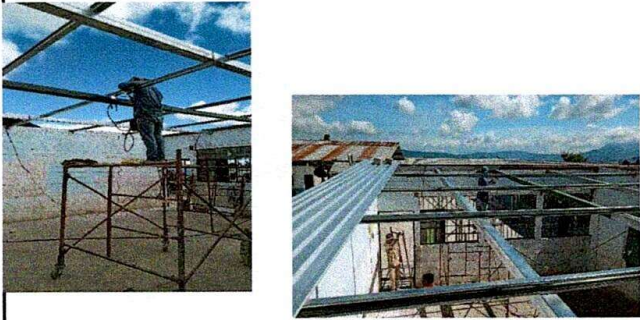
Foto 1: 1 DIRECCIÓN DE LA TARDE PINTADO DE COSTANERAS Y COLOCACION DE LAMINA TROQUELADA
