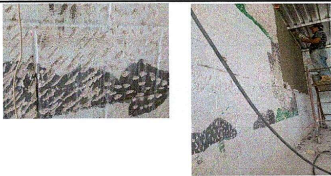
Foto 3: PICADO DE PAREDES DEL SALON DE 1RO. PRIMARIA
