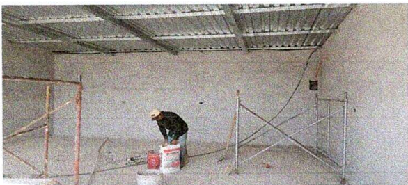
Foto 5: COSTANERAS GALVANIZADAS EN EL SALON DE 1RO, PRIMARIA
