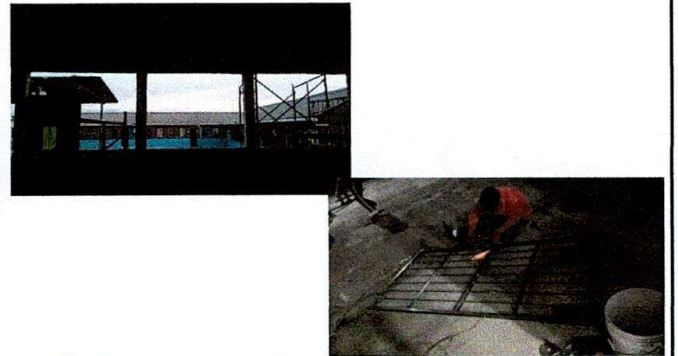
Foto 2: 2 SALÓN 1RO PRIMARIA J.M. DESISTALACION DE VENTANAS Y ELABORACION DE PUERTA BARANDAL.
