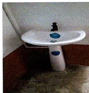
Foto 6: INSTALACION DE LABAMANOS TERMINADO
