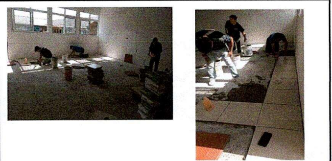
Foto 4: COLOCACIÓN DE PISO CERAMICO DE 1RO PRIMARIA, PEGAMIX,CAPA GRUESA Y SISA.
