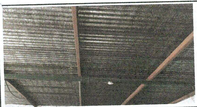
Foto: 5 MANTENIMIENTO DE 1RO PRIMARIA. COSTANERAS GALVANIZADAS, LAMINA TROQUELADA CALIBRE 26, TORNILLOS PULSAR
