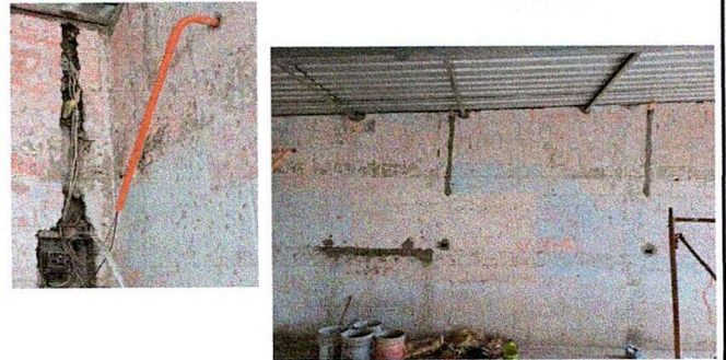
Foto 4: CAMBIO DE CAJA E INSTALACION DE TUBERIA PARA LOS FOCOS.
