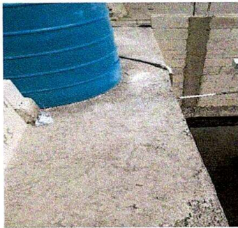
Foto 3: SE COLOCARA UNA FIALA DE BLOCK EN EL AREA DE LA TERRAZA DE LOS SANITARIOS J.M. Y LUEGO UN DESNIVEL CIN TUVOS TENER UNA CAIDA DE AGUA FLUVIAL
