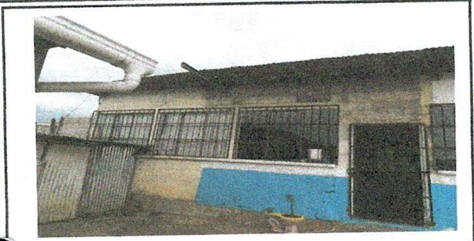
Foto: 1 DIRECCIÓN DE LA J.V. CAMBIO DE LAMINA Y MANTENIMIENTO DE COSTANERAS.
