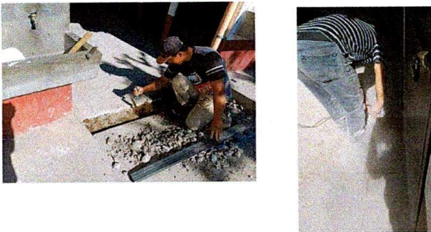
Foto 5: ELABORACION DE REPOSADERA PARA EVITAR QUE AGUA DE LOS SANITARIOS SE RIGUE EN EL PATIO,
