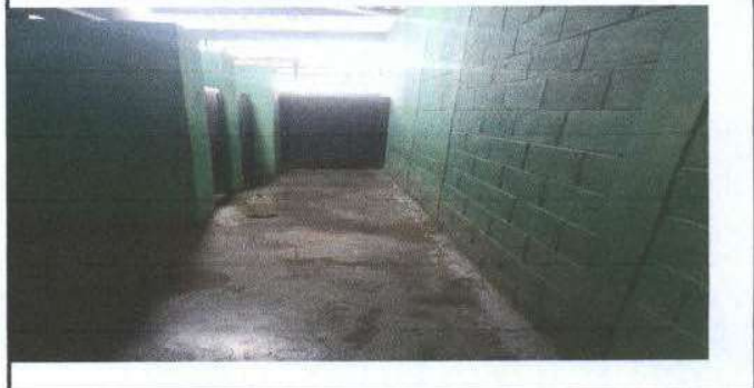
Foto 2: Mejoramiento de baños niñas, piso, baños y puertas.
