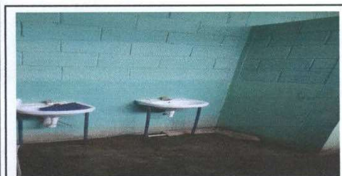
Foto 5: Instalación de 2 baños niños, pared de división y puerta
