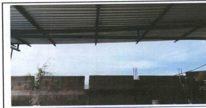
Foto 6: Instalacion de estructura metalica con electromalla
