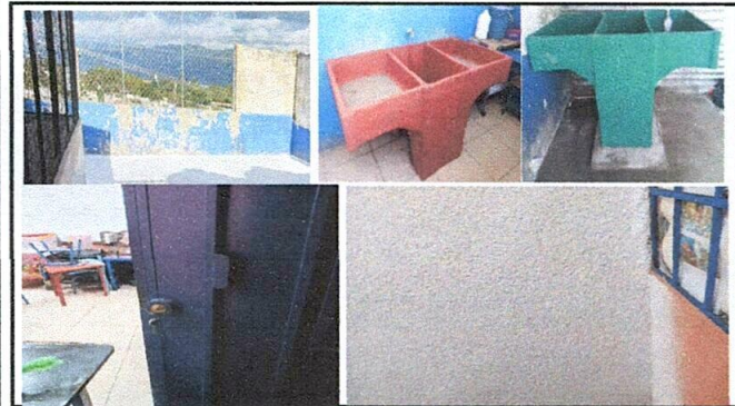
Foto 3: reparación de puerta y cambio de chapa salida de emergencia módulo 2, colocacion de malla modulo 2, cambio de pilas ,modulo 1 y 2
