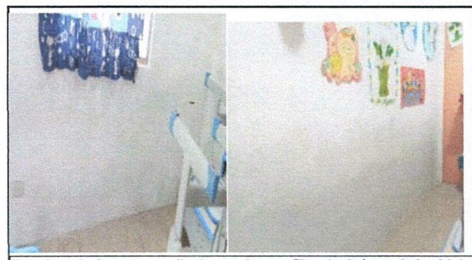
Foto 6: aula de sexto repello de paredes por filtracin de humedad módulo 1
