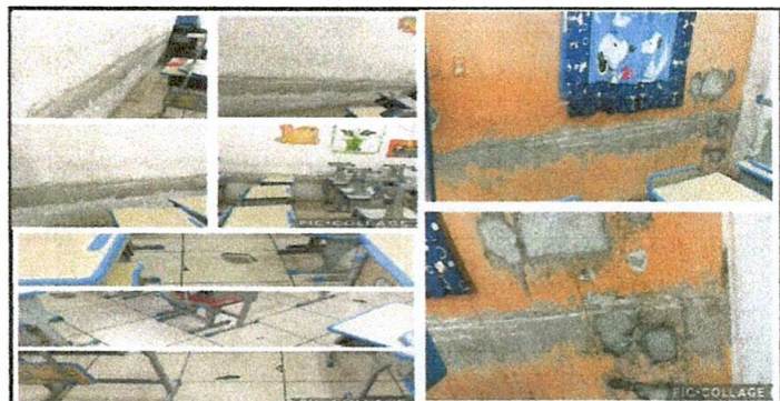
Foto: 6 aula de sexto repello de paredes por filtracin de humedad módulo 1
