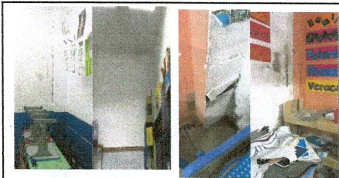
Foto: 5 aulas prepa y tercero repello por filtracion en terraza y pared módulo 1
