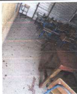
Foto 6: Piso aula No 1 modulo 1 planta alta.
