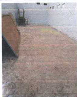
Foto 3: Piso aula No 1 modulo 1 planta baja.
