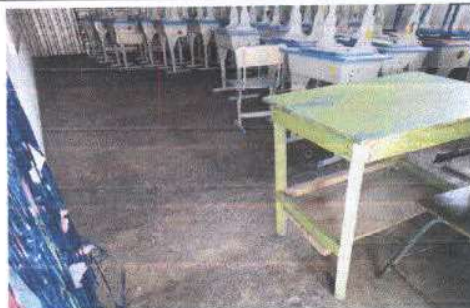
Foto 4: Piso aula No 2 modulo 1 planta baja.
