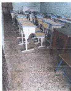
Foto 5: Piso aula No 3 modulo 1 planta baja.
