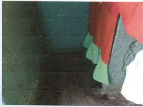
Foto 1: Pintura en estructura y cambio de láminas
