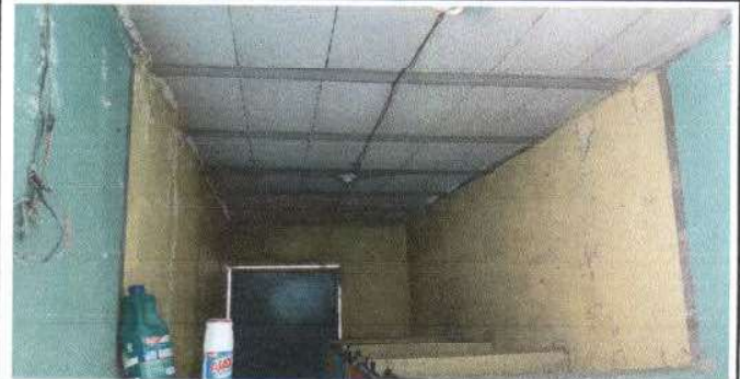
Foto 2: Mejoramiento de sistema eléctrico en aulas y corredor
