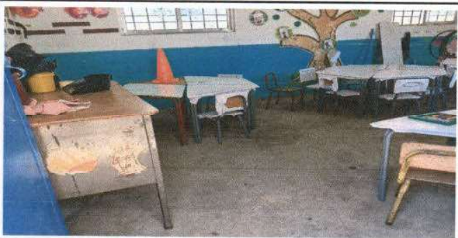
Foto 5: Aulas para intervenir con cambios de laminas
