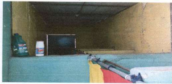
Foto 3: Sustitución de láminas galvanizadas por troqueladas
