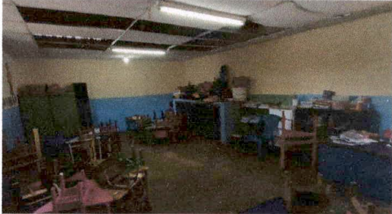
FOTO 10: Se pondrá piso cerámico en las aulas.
