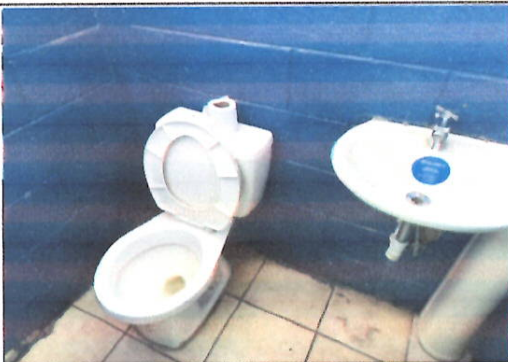
Foto 5: Sanitarios en mal estado, así mismo lavamanos dañados, también es necesario colocar azulejo
