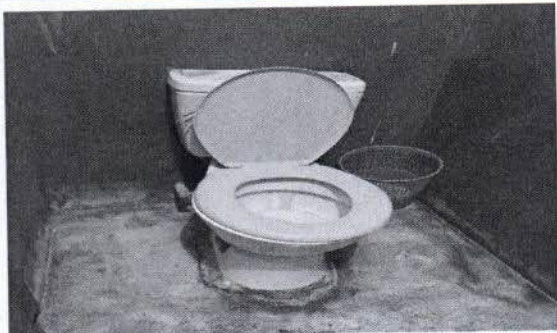
Foto 1.: Mejoramiento de sanitario
