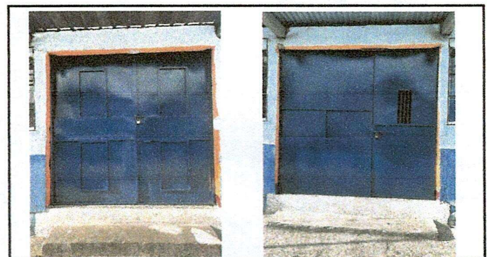
Foto 6: Reparación y pintura de portones
