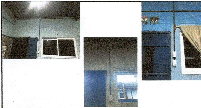
Foto 3: Arreglo e instalación de energía eléctrica en 4 salones.
