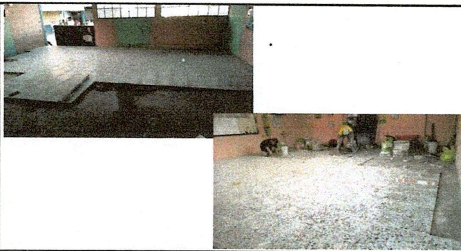
Foto 5: Inicio de colocación de piso de granito.
