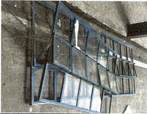
Foto 1: Desmontaje de ventanería de hierro.
