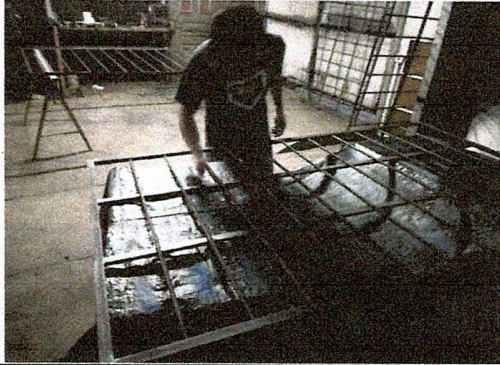
Foto1: Elaboración e instalación de balcones de metal
