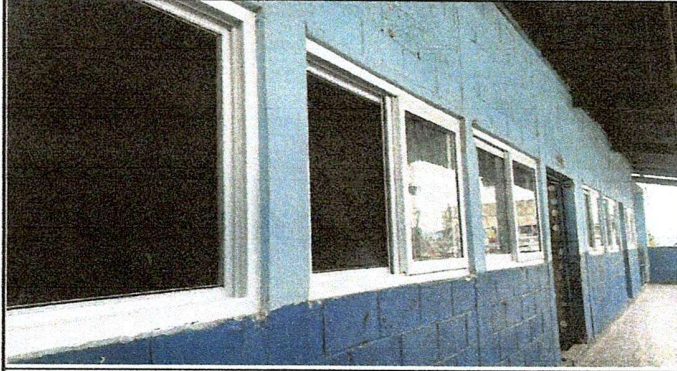
Foto1: Elaboración e instalación de balcones de metal
