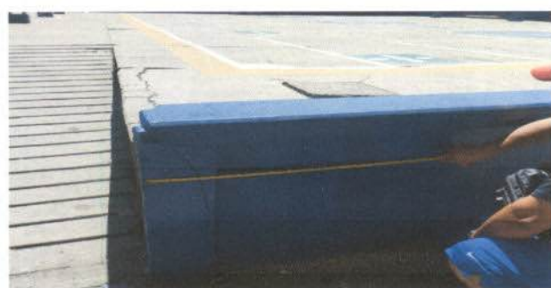
Foto 5: Corte de muro para ampliar rampa
