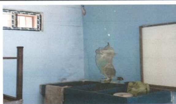
Foto 4: Remozamiento en paredes y pilas
