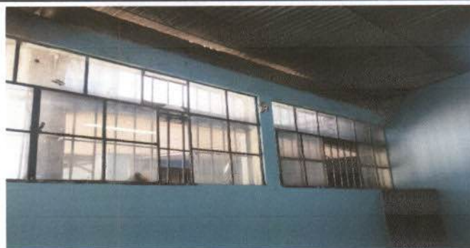
Foto 2: Cambio de ventana
