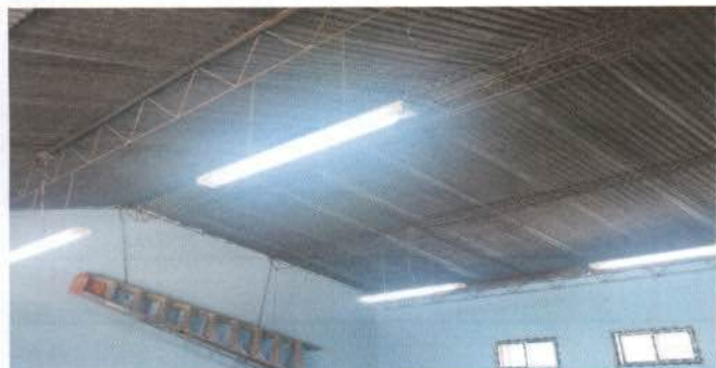
Foto 1: Cambio de lamina y mejoramiento del sistema electrico
