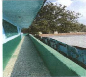
Foto 4: Colocacion de gradas para facilitar circulacion de estudiantes y evitar accidentes.
