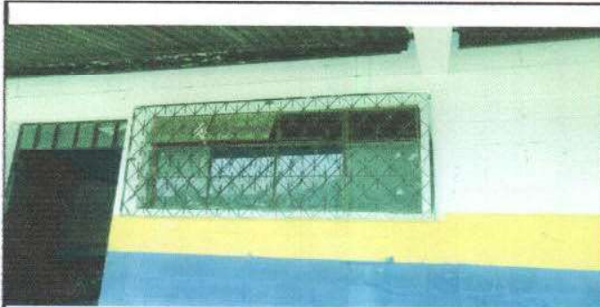
Foto 6: CAMBIO DE VENTANAS
