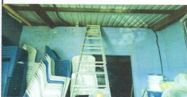
Foto 1: DEMOLICIÓN DE PARED PARA PODER AMPLIAR LA COCINA
