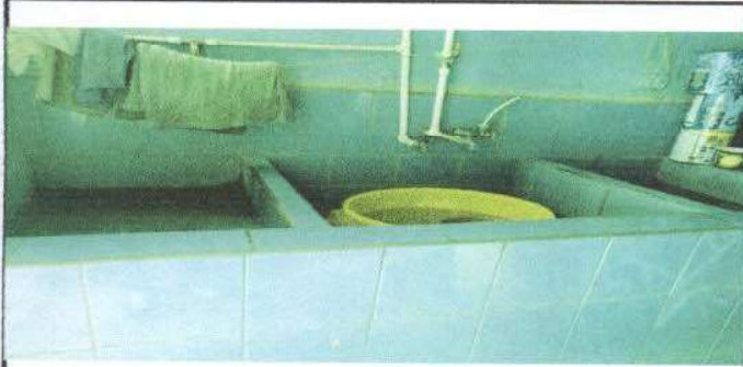
Foto 3: DEMOLICIÓN DE PILA, NO FUNCIONA PORQUE SE FILTRA EL AGUA
