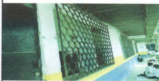
Foto 4: CAMBIO DE VENTANAS .
