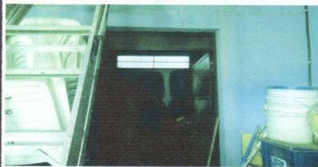
Foto 2: SE UNIRÁ COCINA CON BODEGA
