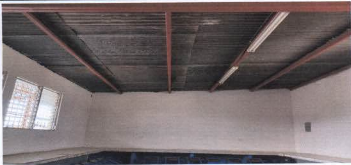
Foto 1: Estructura en aulas lado sur con dos aulas
