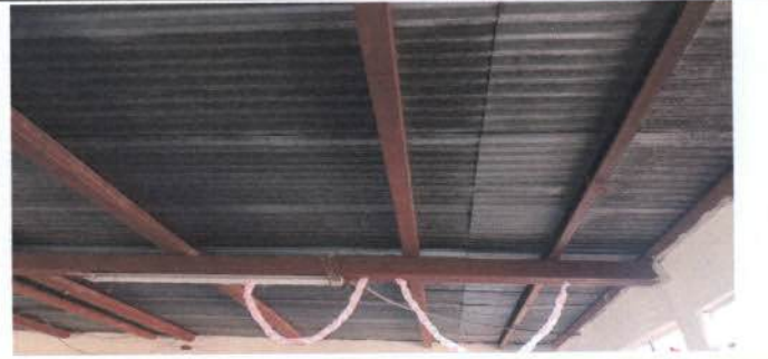
Foto 6: Mejoramiento en sistema electrico
