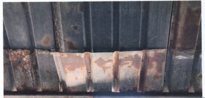
Foto 2: Laminas para acceso en el segundo nivel
