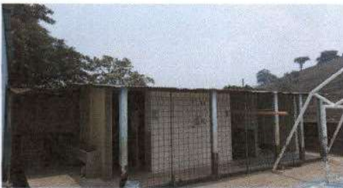
Foto 3.: Cambio de lamina de sanitarios
