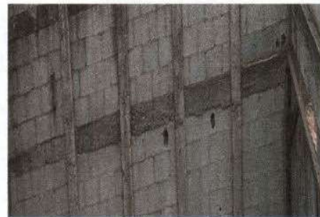
Foto 4.: Remozamiento de muro
